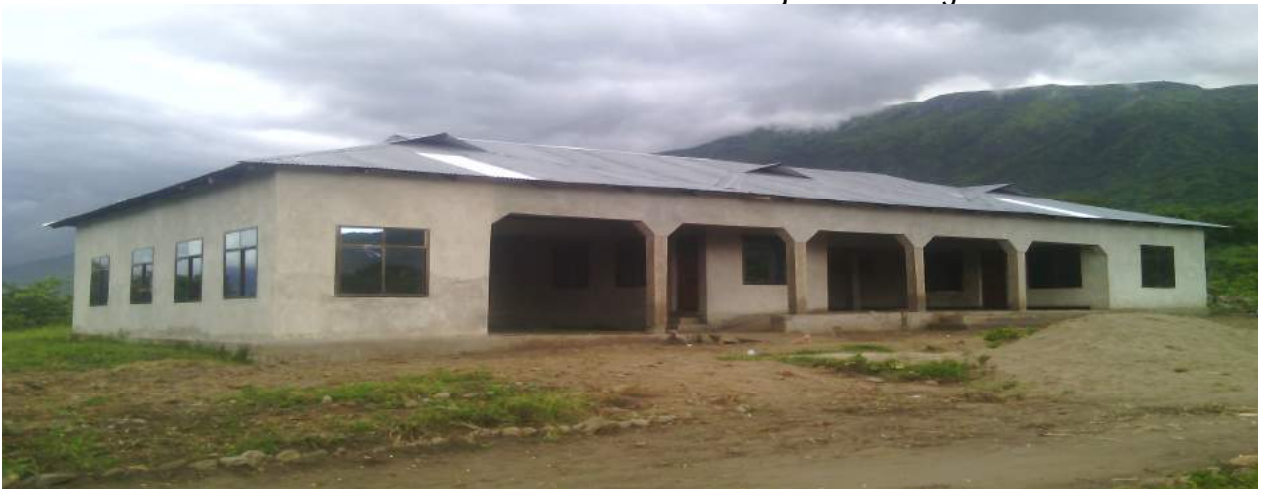
Ujenzi wa Zahanati ya Kijiji Cha Kinambo – Kata ya Milepa MWENGE OYEEEE!!!!!!!!!!!!!!
