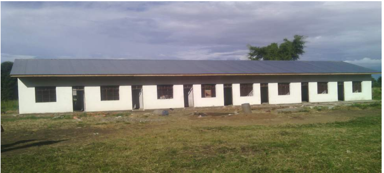
Ujenzi wa Nyumba ya Walimu 6 Shule ya Sekondari Milenia – Kata ya Milepa
